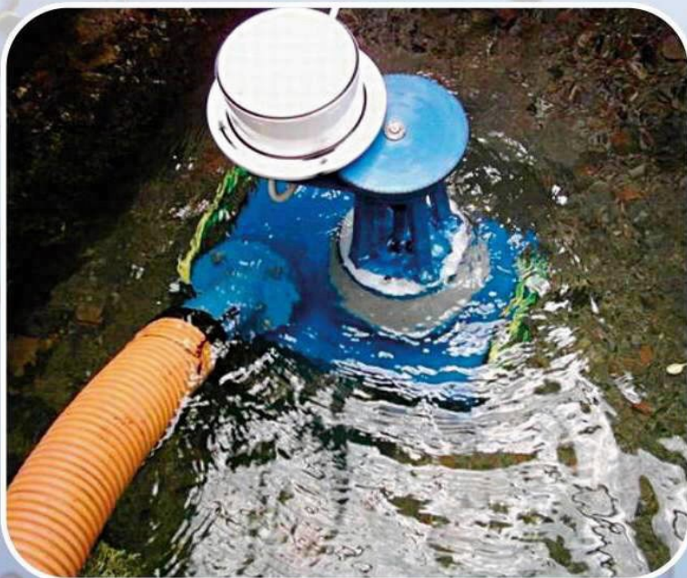
Sv. Ján pod Skalou. Inštalácia DVE 120, DC generátor 12 V.
