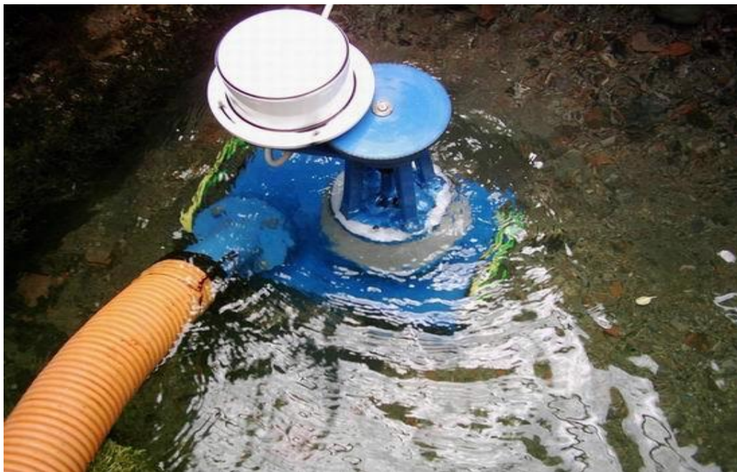
Sv. Ján pod Skalou. Inštalácia DVE 120, DC generátor 12 V.
